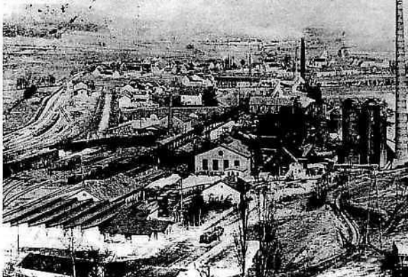
Unterwellenborn b. Saalfeld a. S. mit Eisenhüttenwerk Maxhütte.
